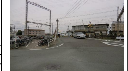
※写真(上)は、県道166号沿線 写真(下)は、松阪駅南側駐輪場付近
