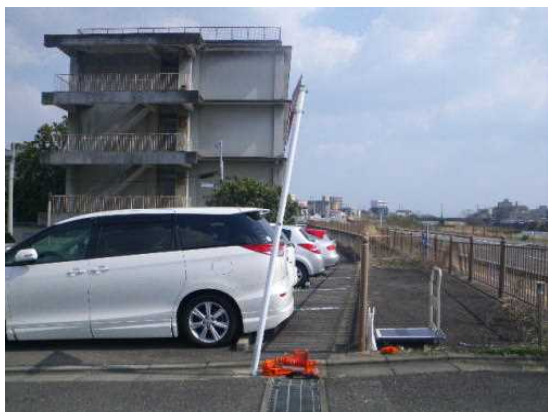
【傾斜した道路標識】
