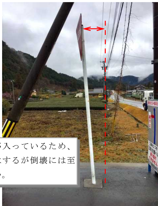
【鉄心により倒壊しない状態】
