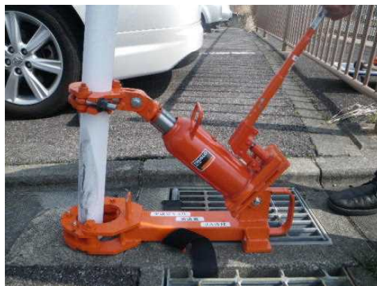
【油圧により押し戻して補修】
