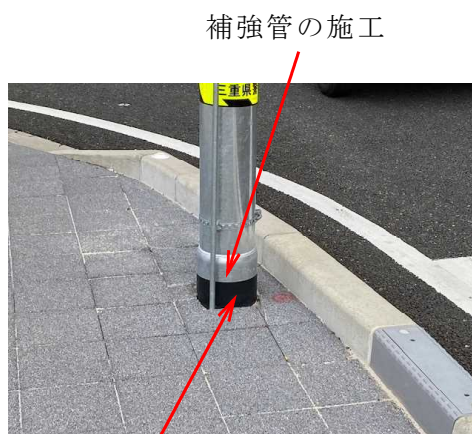
防錆塗装の施工
