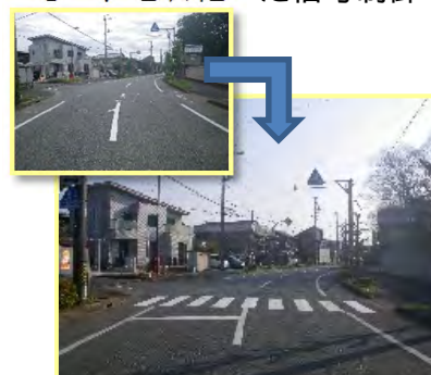
横断歩道の塗り替え状況
