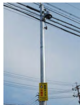
街頭防犯カメラの設置
