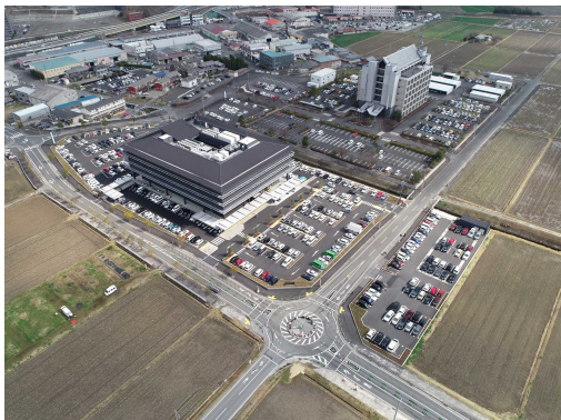
伊賀市(伊賀市役所前市道)
